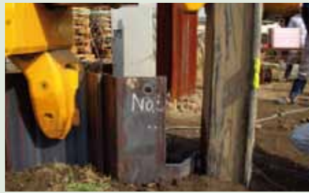
●角部搭接施工
