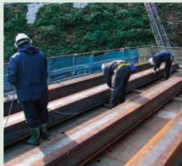
● 将止水橡胶安装至口袋部
