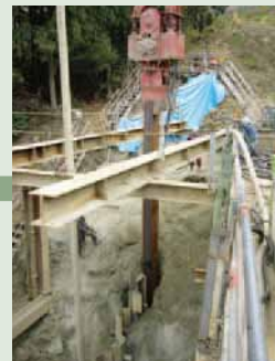
● 使用振动打桩机打入
